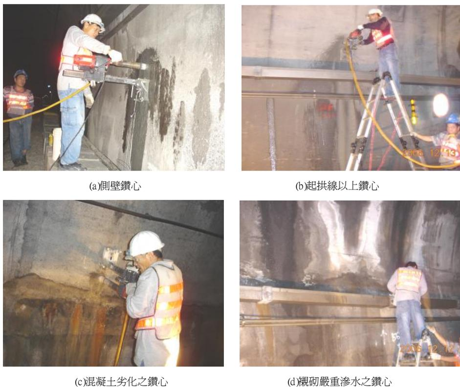
圖 61 鑽心取樣現場作業照片
