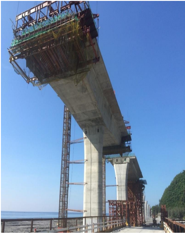
圖 21：臺鐵金崙火車站之月台與台 9 線省道臺東縣金崙大橋懸臂推進工法與。(賴品寬攝)
