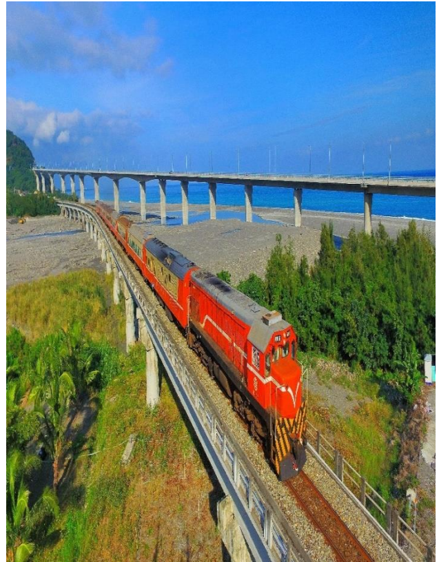
圖 22：臺鐵南迴線金崙鐵道橋客車之美遠映台 9 線省道金崙大橋與太平洋西岸沙灘。(王富生攝)
