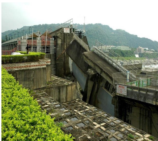
圖 13：921 集集大地震對臺中石岡壩主壩 16~18 號洩水口遭斷層的逆衝切斷破壞。(賴明煌攝)
