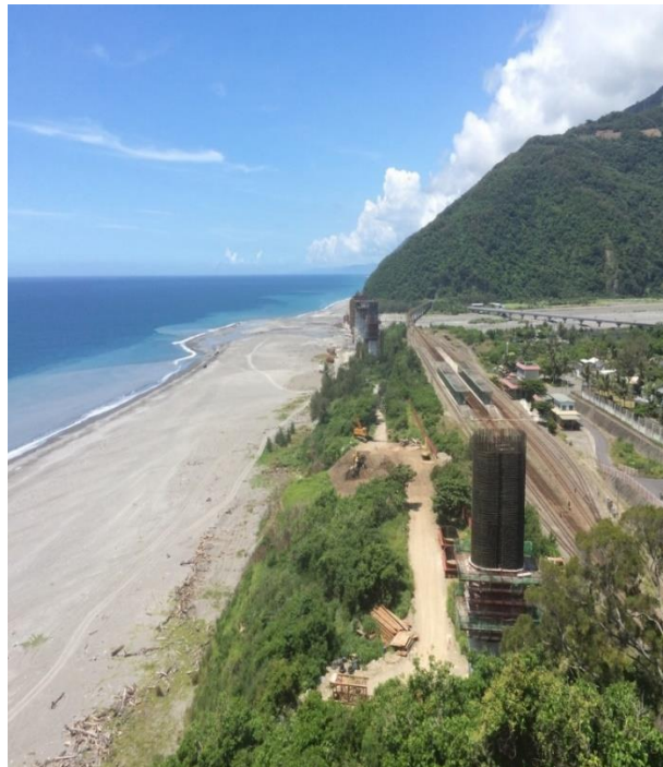
圖 20：臺鐵金崙火車站整體場站與台 9 線省道金崙大橋北端橋墩與西側海灘。(賴品寬攝)
