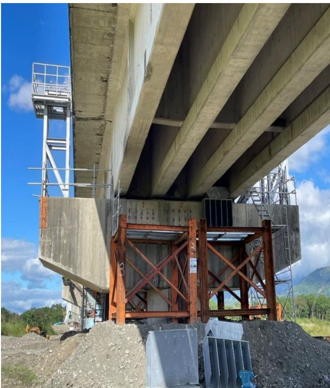
圖 53：2022 年 918 池上地震臺鐵新秀姑巒溪橋修復，原帽梁植筋來裝設防落橋裝置圖。(賴品寬攝)
