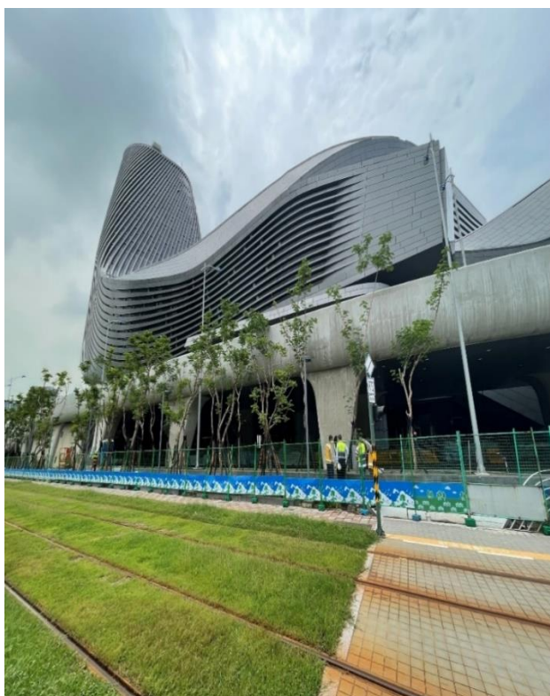
圖 17：某港旅運大樓號稱是艘銀白色大鯨魚帷幕大樓有數十萬張施工圖頗困難建築。(賴明煌攝)
