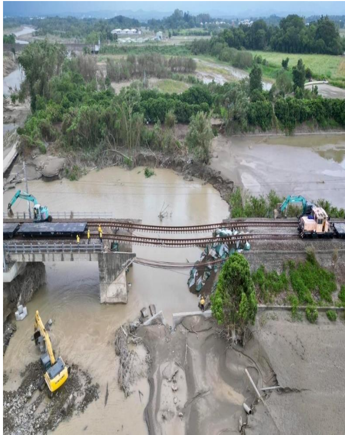
圖 67：交通部與臺鐵工程人員積極搶修臺鐵縱貫與潰堤線八掌溪鐵道橋路基以利通車(摘自「台南式 Tainan Style」)
