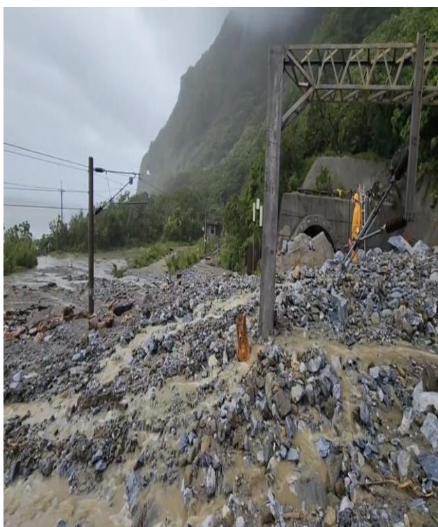
圖 63：凱米颱風降雨釀臺鐵新和仁隧道北口東西正線隧道斷面幾乎遭大量土石流崩塌淹蓋斷線(摘自臺鐵資料)。
