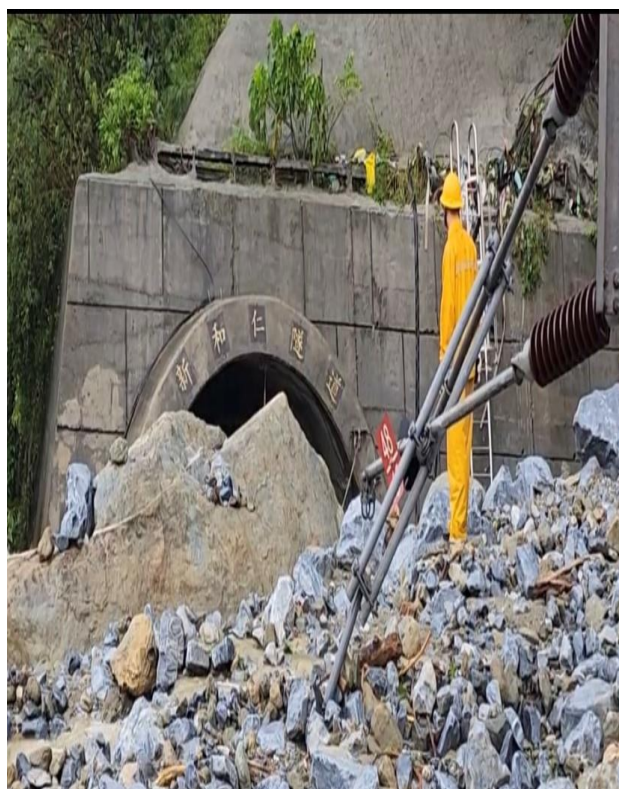
圖 62：凱米颱風大降雨釀臺鐵新和仁隧道北口東西正線均遭大量土石流崩塌淹蓋(摘自臺鐵)。
