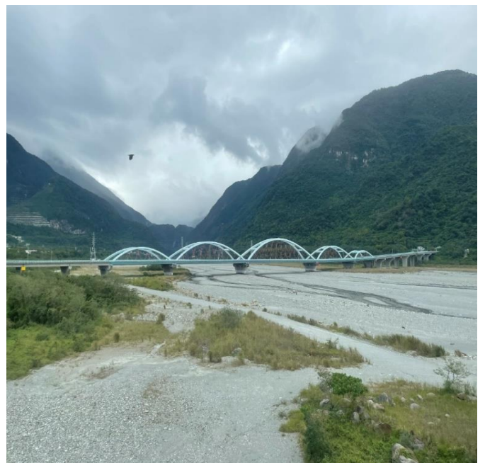
圖 28：自臺鐵立霧溪橋眺台 9 線省道太魯閣橋 5 大主鋼拱橋跨係採簡支紐爾遜鋼拱橋 (Network Arch Bridge)。(賴品寬攝)
