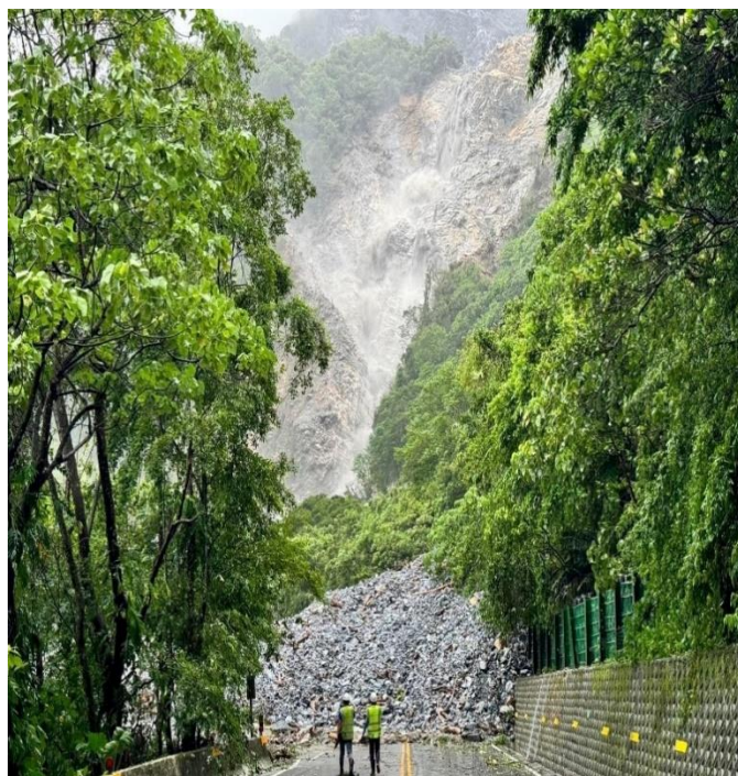
圖 64：圖 62：凱米颱風大降雨釀臺鐵新和仁隧道北口東西正線均遭大量土石流崩塌淹蓋(摘自臺鐵資料)
