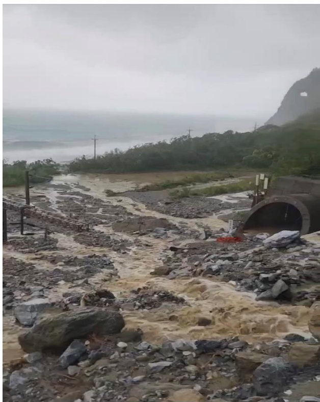
圖 61：凱米颱風龐大降雨釀臺鐵崇德隧道大量土石流崩塌(摘自臺鐵)。
