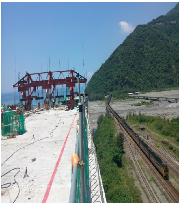
圖 19：臺鐵舊的自強號柴油列車駛過金崙鐵路橋與台 9 線金崙大橋懸臂推進工法。(賴品寬攝)
