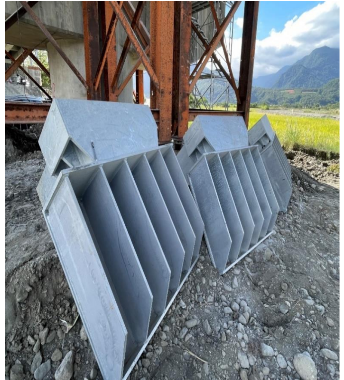
圖 52：2022 年 918 池上地震臺鐵新秀姑巒溪橋修復用 t=30 公分鋼製防落橋裝置圖。(賴品寬攝)
