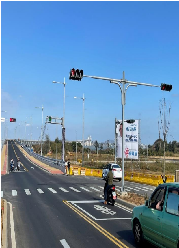
圖 25：連接大小金門之金門大橋西入口引道與烈嶼首座紅綠燈設在橋頭。(賴明煌攝)
