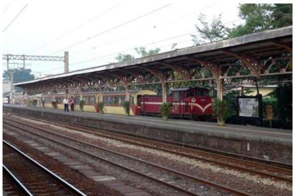
▲ 臺鐵與林鐵共用嘉義站第一月台。
