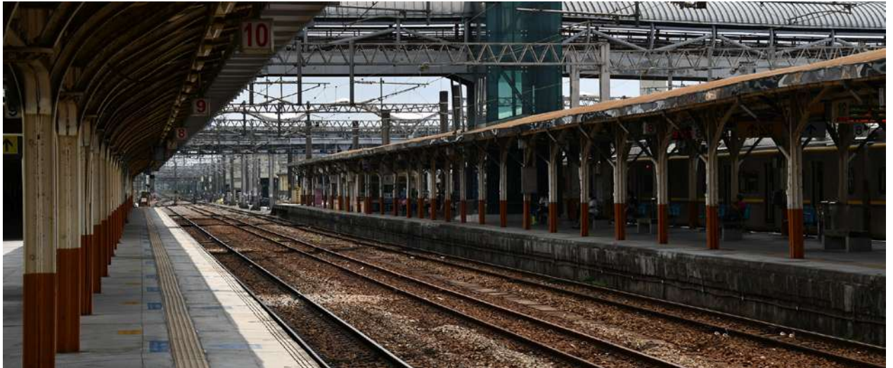
▲ 臺鐵與林鐵共用嘉義站第一月台。
