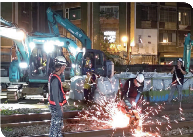
▲道班軌道切換鋸軌作業
