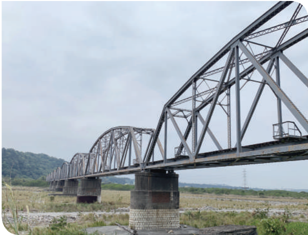
▲大安溪花梁鋼橋
