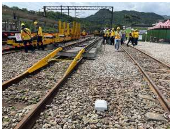
▲ 軌框搬運車執行PC枕佈放
