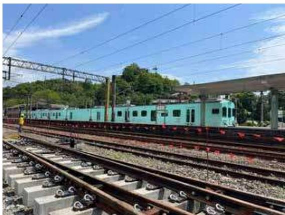
▲ PC枕型道岔於雙溪站工區組裝
