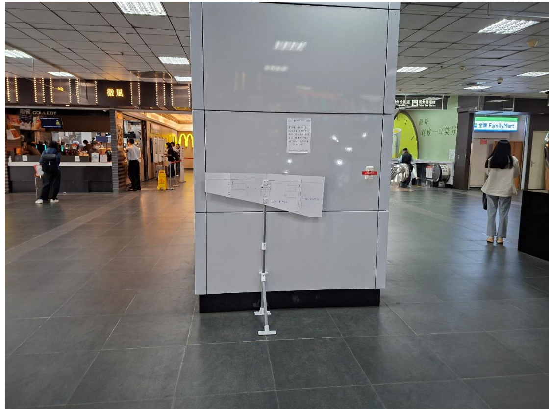
臺北站北 1 門室內柱 (寬 100 公分、深 24 公分、高 130 公分)
