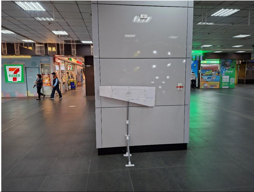
臺北站北 3 門室內柱 (寬 100 公分、深 24 公分、高 130 公分)
