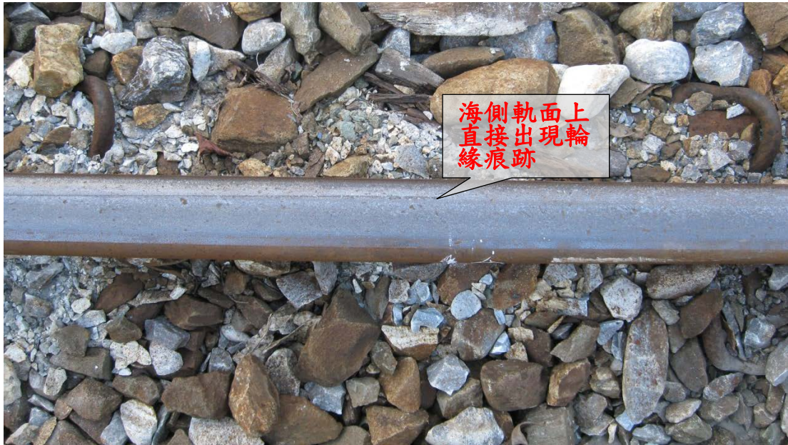
圖3 在海測軌面上直接出現輪緣痕跡
