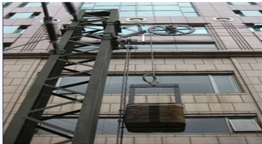
圖 4.21 自動平衡錘裝置
