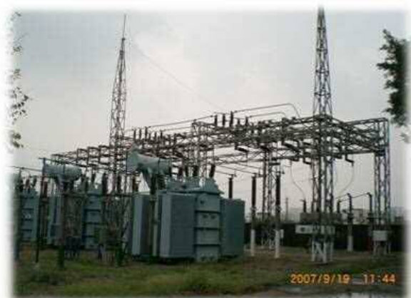
圖 1.35 10MVA 變壓器
