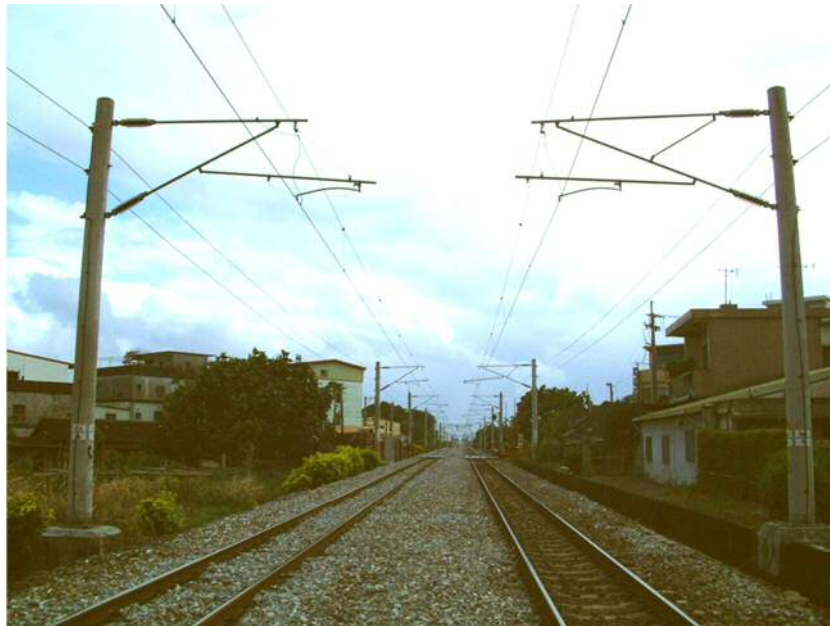
圖 4.18 電桿及電車線
