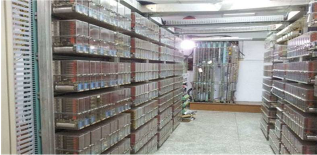
圖 1.9 繼電聯鎖(繼電器架)
