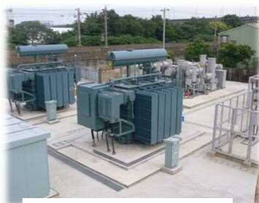
圖 1.36 25MVA 變壓器
