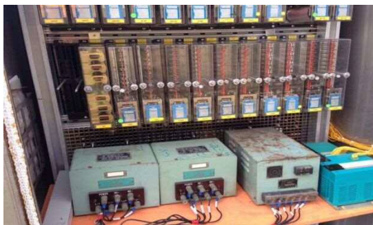
圖 4.8 平交道繼電式控制組
