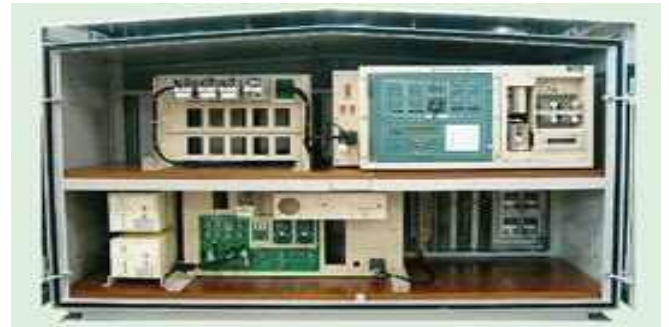
圖 4.9 平交道電子式控制組
