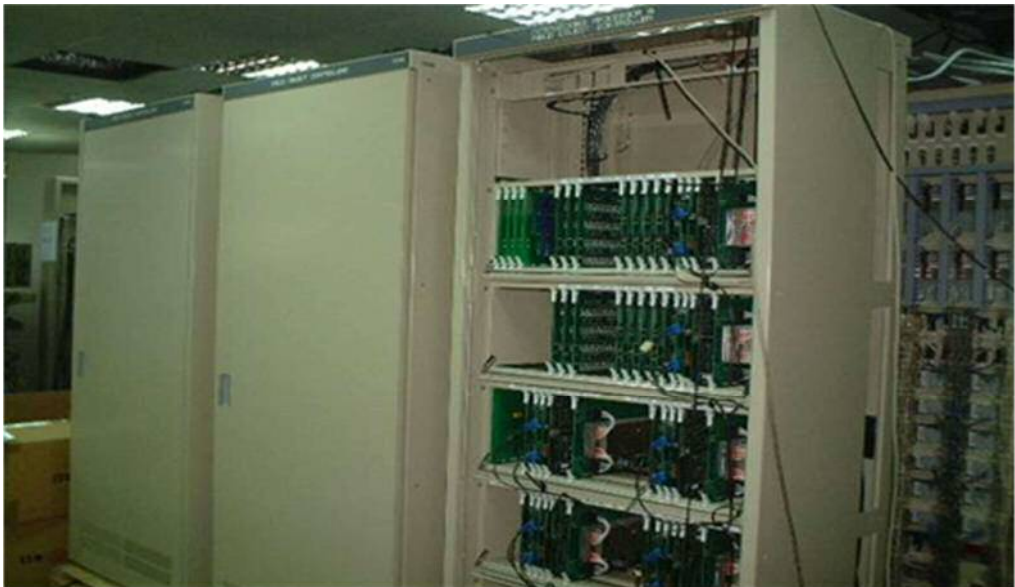
圖 1.9 繼電聯鎖(繼電器架)
