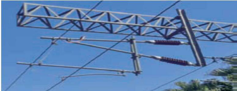
圖 1.29 懸臂組、小鋼件銹蝕情形
