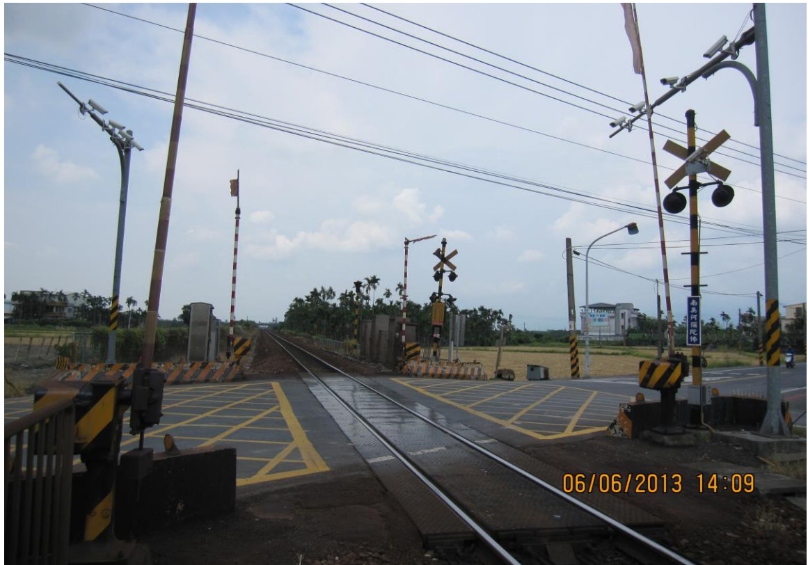
崁頂（招呼）站北端田寮路平交道(由南向北方向)
