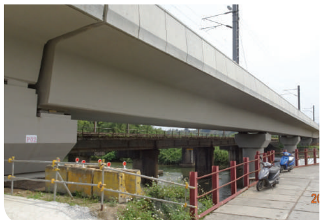
▲高架橋梁段完成現況
