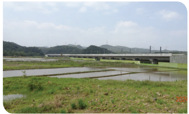
▲第三雙溪橋及新社橋完成現況
